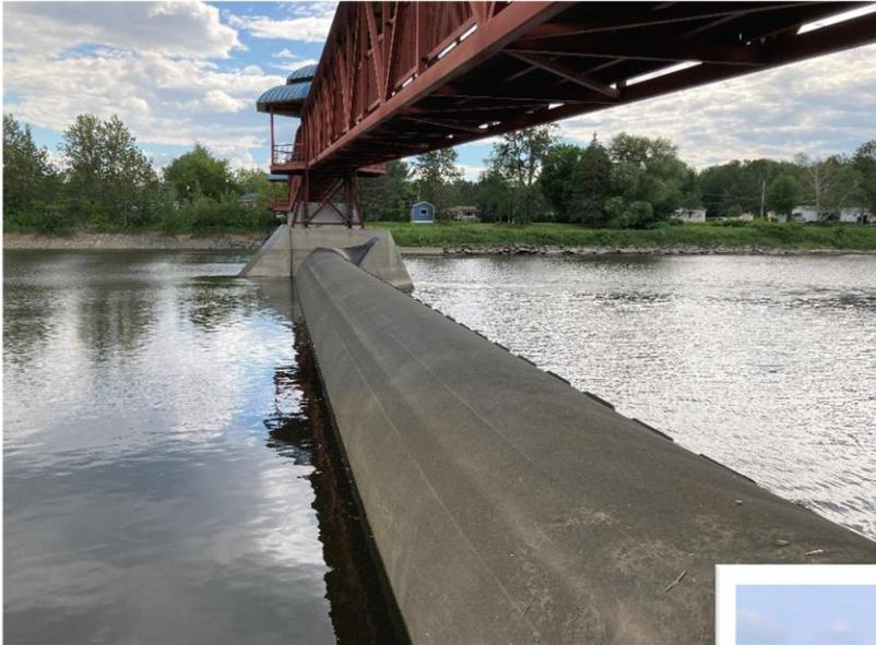
Pour résumer rapidement, le barrage gonflable est fait de 2 ballons de 50 mètres de longueur par 2 mètres de hauteur.
